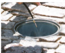
Manguera de limpieza de tuberías
